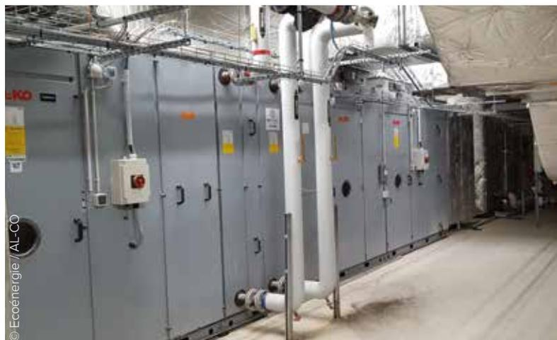
Au total, les deux halles bassins disposent de 2 CTA thermodynamique de déshumidification (15 000 et 30 000 m<sup>3</sup>/h) et de 3 CTA de déshumidification en modulation d'air neuf (40 000 m<sup>3</sup>/h chacune).
